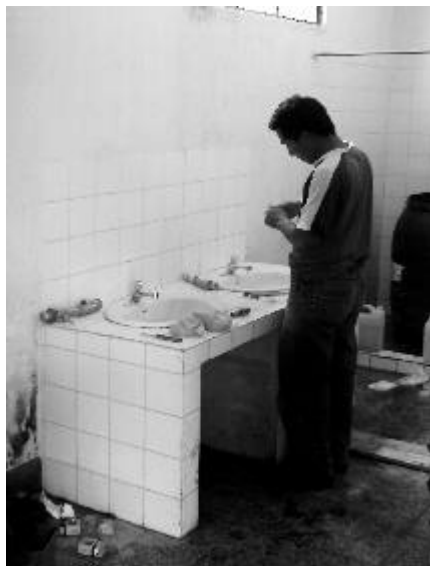
Installation eines Waschräume
