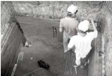
Bau des Auffang-Beckens für die Wasserversorgung...
